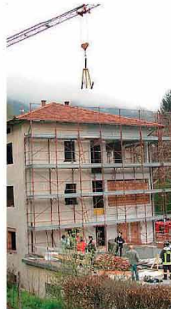
Un cantiere: il settore edile continua a essere in sofferenza e nel 2011 le ore di cassa integrazione sono aumentate del 200% rispetto al 2010
